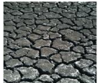
التشققات الطينية Mud Cracks
